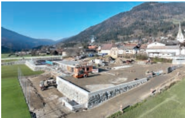
Übersichtsfoto-1 ➔ Natursteinmauern mit STB-Randbalken, Sanierung und Erweiterung des Kabinengebäudes sowie Herstellung der Außenanlagen und Zaunanlagen.
