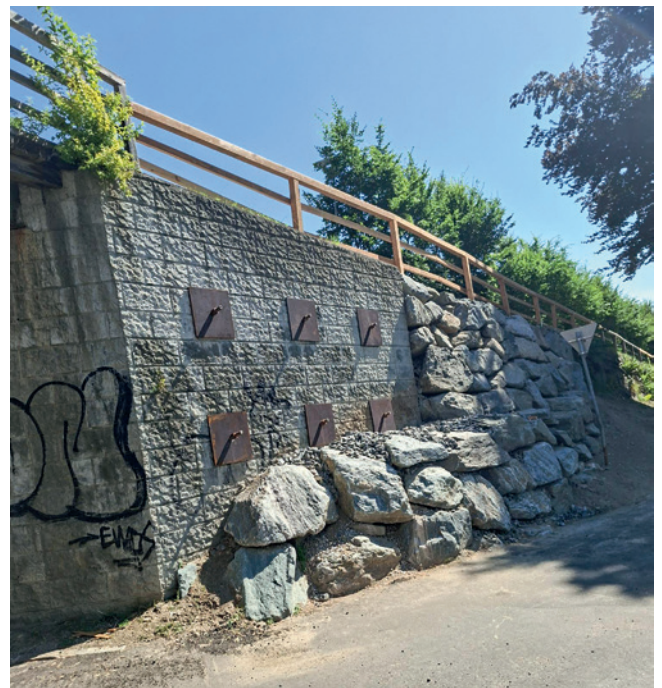
Sanierung Radweg in Sattendorf mit Ankern
