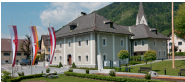
Umbau Gemeindeamt Treffen, barrierefrei gemacht und sämtliche Räumlichkeiten modernisiert.
