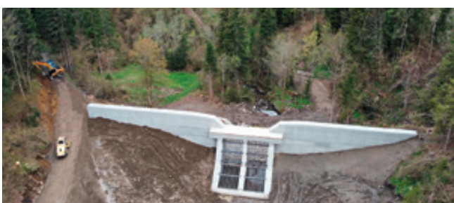
Rückhaltesperre Pöllingerbach, in Pölling – Ausbau im Vorfeld stark kritisiert – schützte ca. 40 Objekte und rettete Menschenleben.
