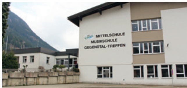
Generalsanierung der Mittelschule Gegendtal Treffen mit Integrierung der Musikschule Gegendtal Bodensdorf sowie der Marktmusik Treffen im Gebäude.
