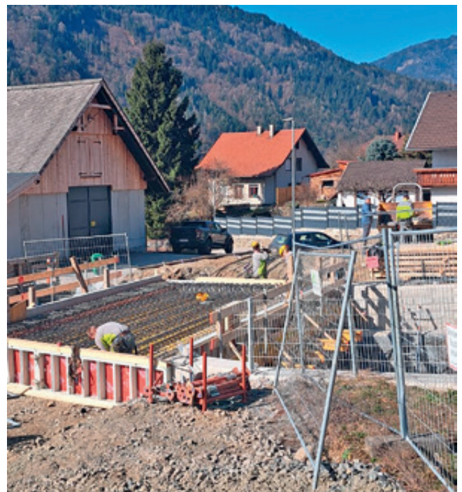
Schalungs- und Bewehrungsarbeiten an der neuen Katholnigbrücke
