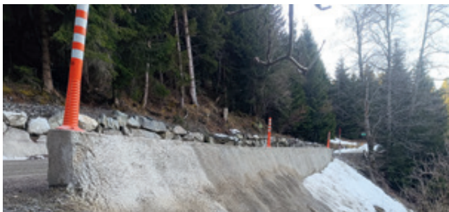
Generalsanierung der Gerlitzenstrasse Treffen , nach mehreren Rutschungen und Generalsperre der Straße.
