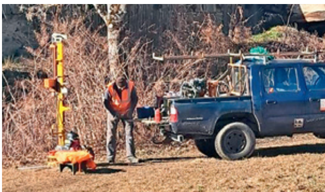
Durchführung der Rammsondierungen für die Schlosstraßenbrücke
