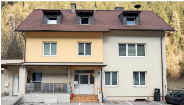
Generalsanierung Wohnhaus Einöde
