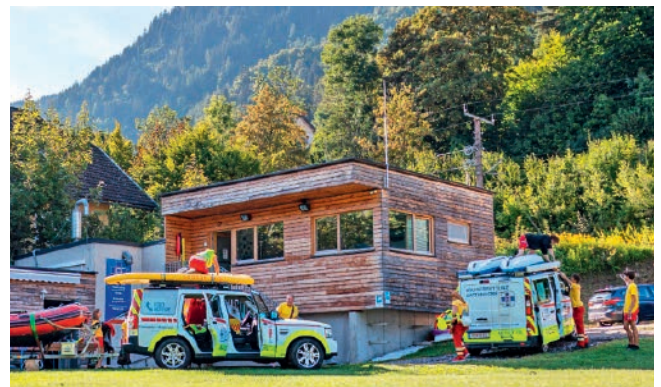
Neue Einsatzzentrale der ÖWR Einsatzstelle Sattendorf
