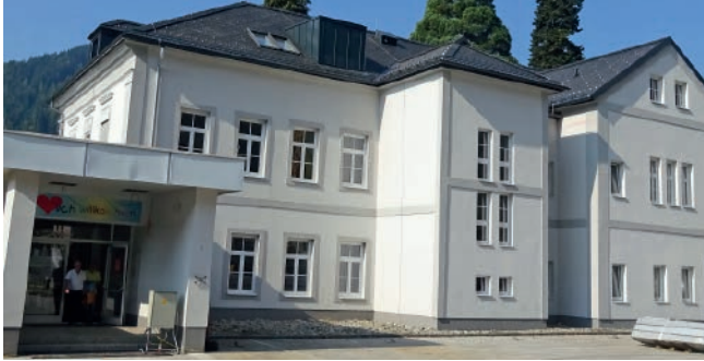
Generalsanierung VS Treffen
