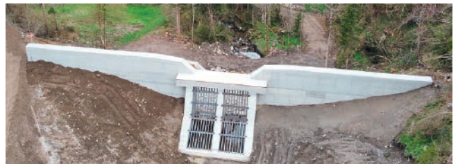
Neuerrichtung Rückhaltesperre Pöllingerbach
