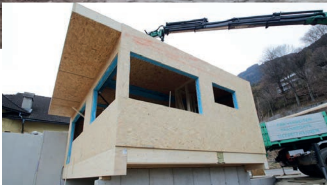
Versetzarbeiten der konstruktiven Bauteile.
