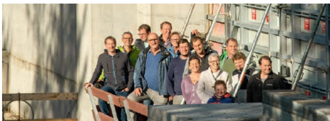
Baustelle am Pöllingerbach
