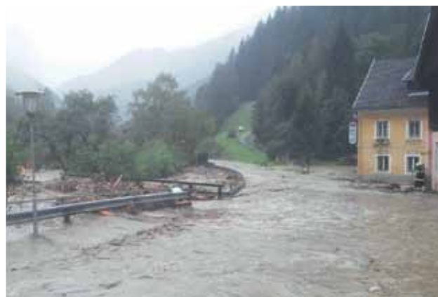
Hochwasser in der Einöde im Bereich Gasthof Zlattinger
