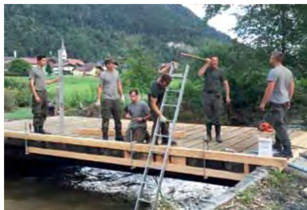
10 Pioniere bei der Sanierung von 5 zerstörten Brücken – Villacher Pioniere des Österreichischen Bundesheeres im Assistenzeinsatz
