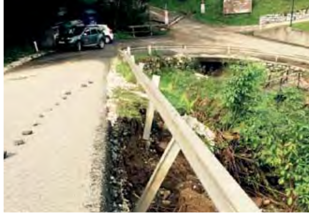
Hangrutschung bei der Verditzerstraße
