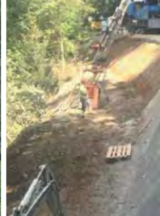
Sanierungsmaßnahmen an der
