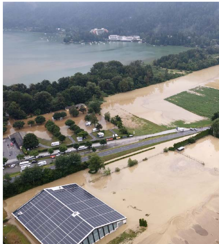
Bis nach Annenheim reichte die schreckliche Überflutung. Sie füllte Keller, mit Schlamm.
