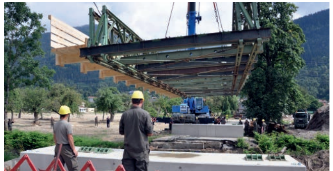
Das Bundesheer half mit Notbrücken, damit abgeschnittene Gemeindeteile und deren Bewohner wieder erreichbar waren.
